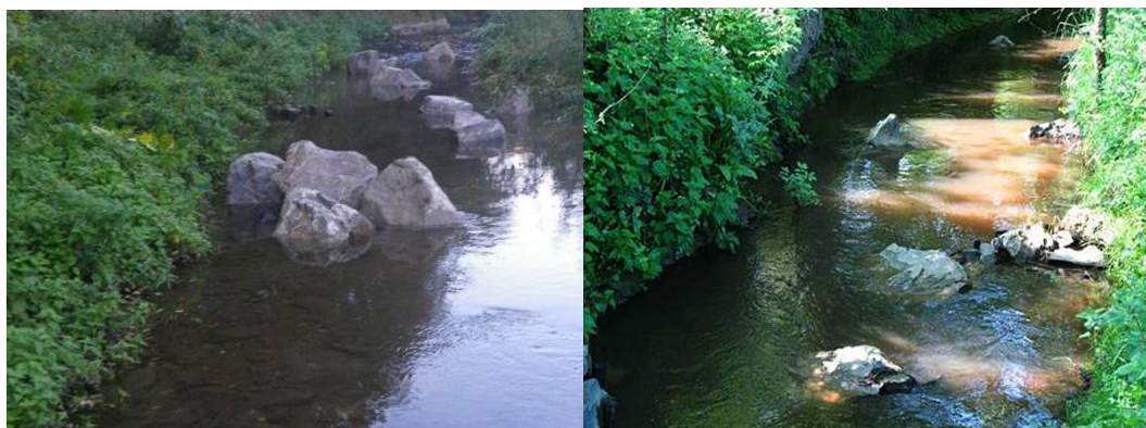
Photo 2 : Exemples de blocs disposés pour diversifier les écoulements
