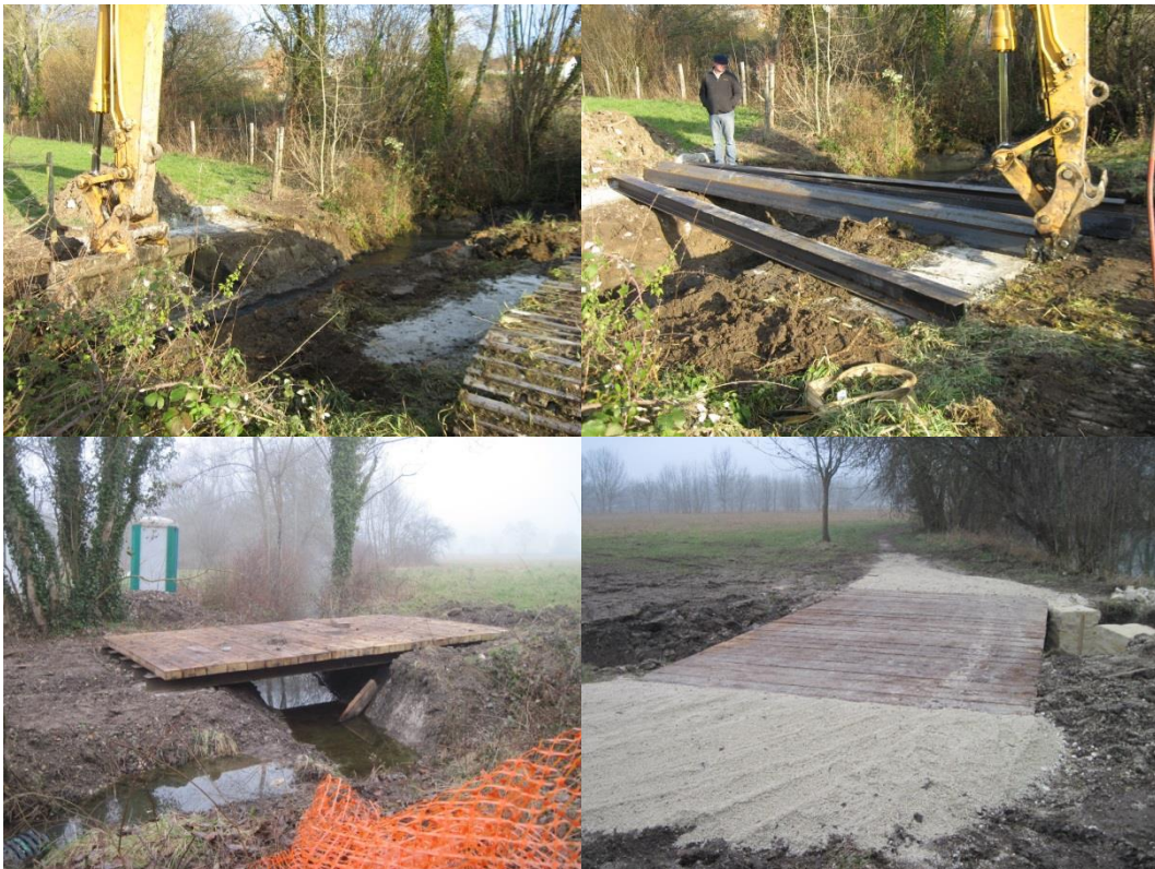
Photo 13 : Exemple de mise en œuvre d'une passerelle IPN et platelage bois
