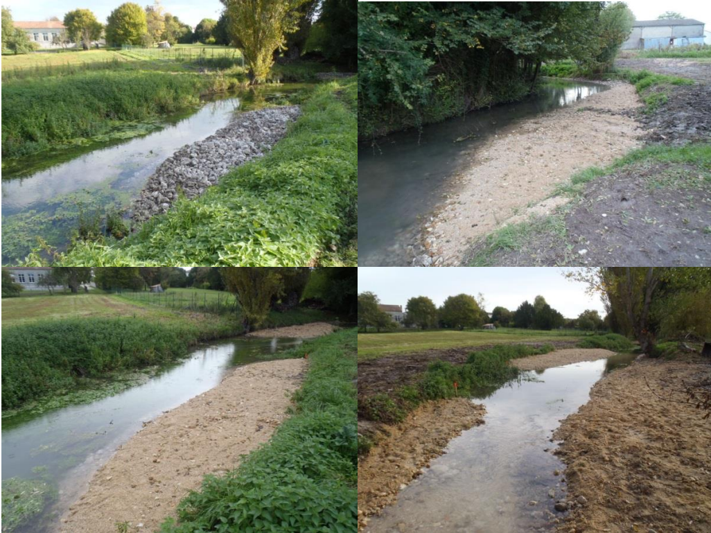
Photo 3 : Exemples de banquettes minérales alternées (SIAH du Taillon, 2015)
