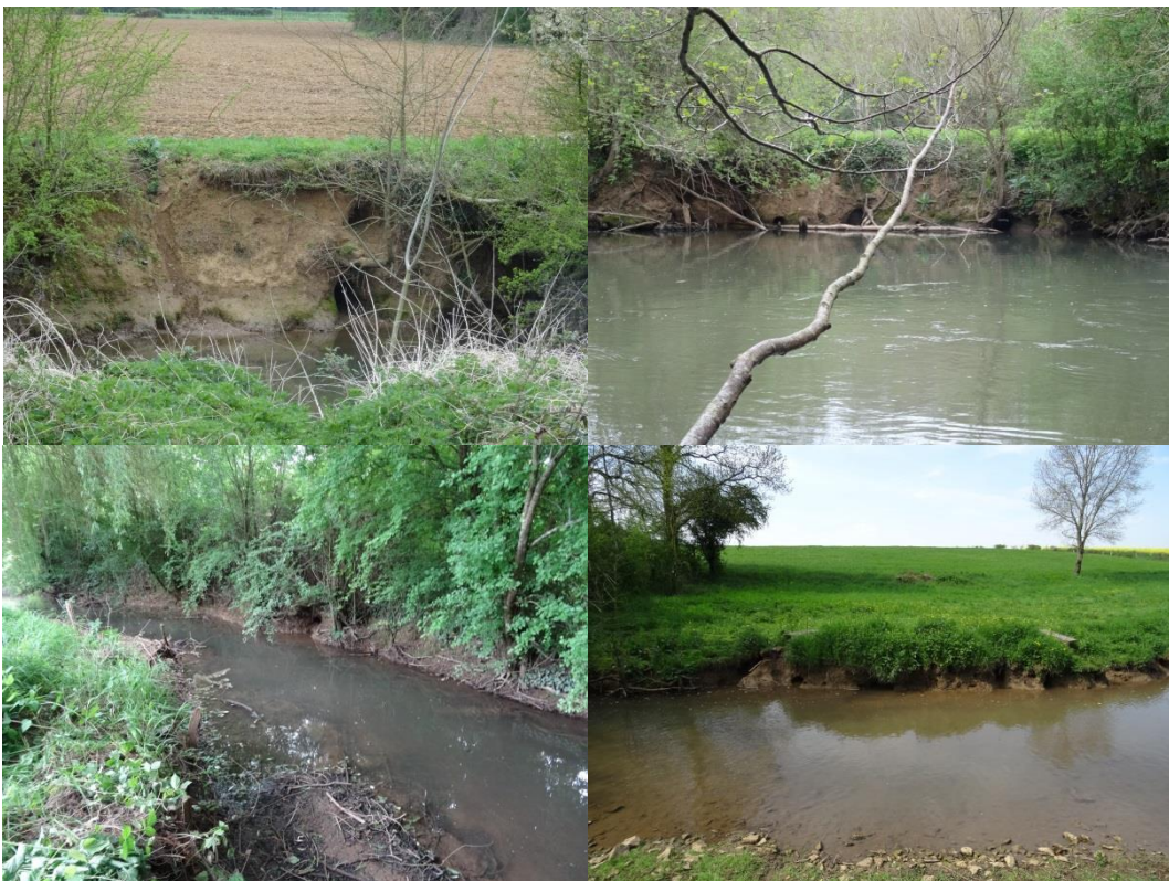
Photo 9 : Exemples de berges dégradées par les ragondins
