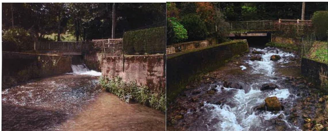
Photo 15 : Exemple de recharge granulométrique en aval d'un ouvrage de franchissement
