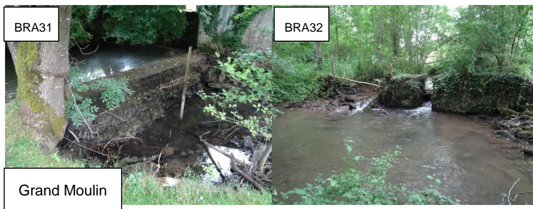
Photo 17 : Ouvrages du Brangeard pouvant faire l'objet d'un démantèlement ou d'un arasement
