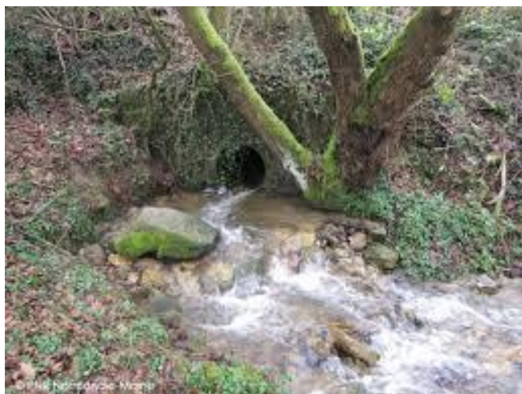
Photo 16 : Exemple de recharge granulométrique en aval d'une buse
