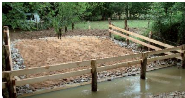
Photo 6 : Exemple de descente aménagée
